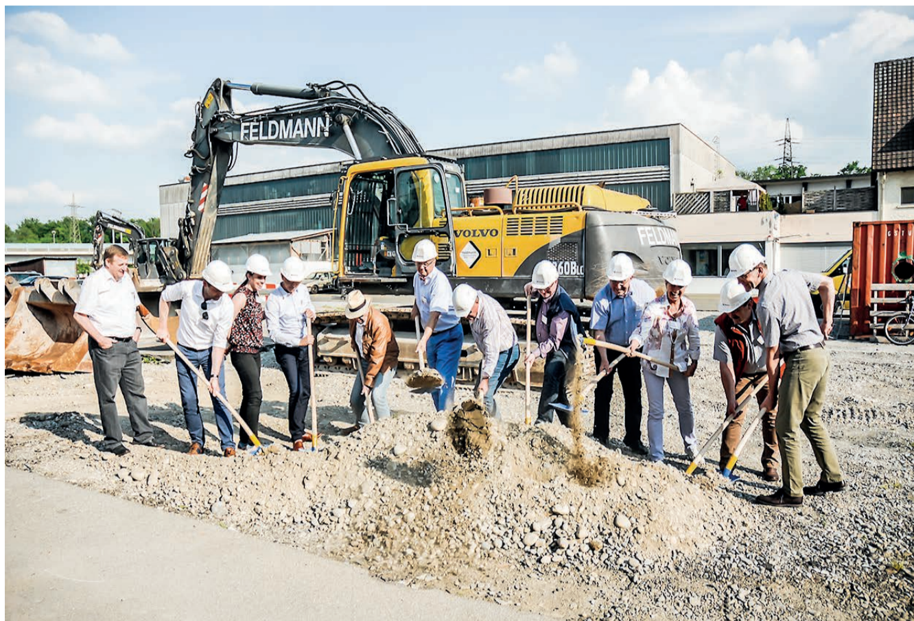
Der erste Spatenstich ist gemacht, der Baustart ist Mitte Mai.
